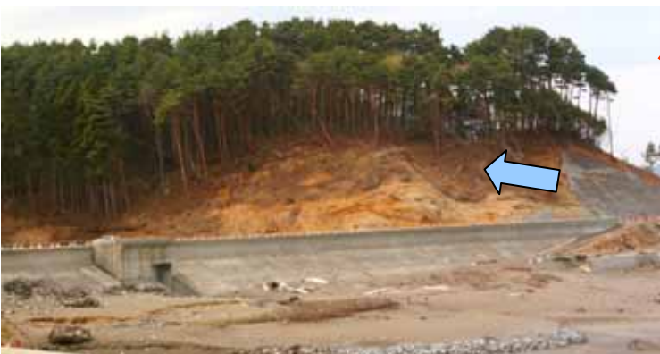
Fig. 40 堤防脇の岸壁に津波が駆け上がり、植生を破壊し ながら、防潮堤の堤内に流入（九戸郡野田村十府 ヶ浦 下安家）
