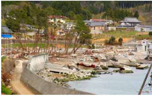
Fig. 25 津波の引き波で防潮堤が破壊、海岸松林も大きく損傷した（岩手県大船渡市碁石）
