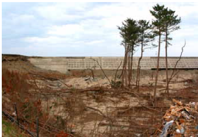
Fig. 22 防潮堤を津波が越流、海岸松林を破壊した (岩手県下閉伊郡岩泉町小本小浜崎)
