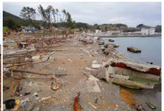
Fig. 23 防潮堤を破壊し、海岸松林もほとんど破壊 (岩手県大船渡市小友浦谷地)
