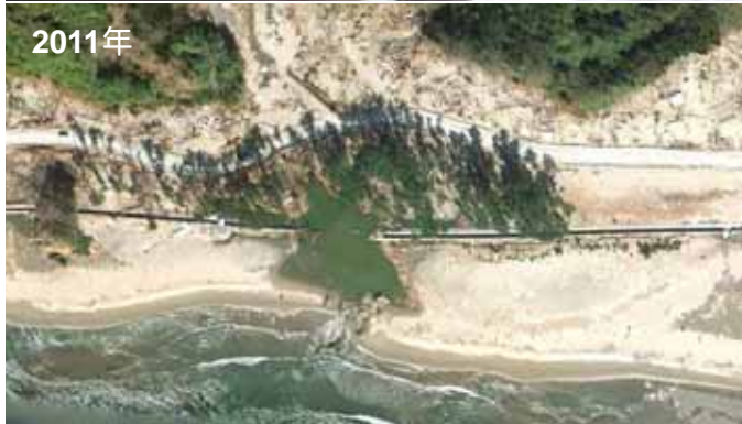
Fig. 19 津波前後の石巻市白浜海岸のクロマツ海岸林。地盤の弱い小河川沿いに砂浜が集中的に浸食され、堤防も破堤している
