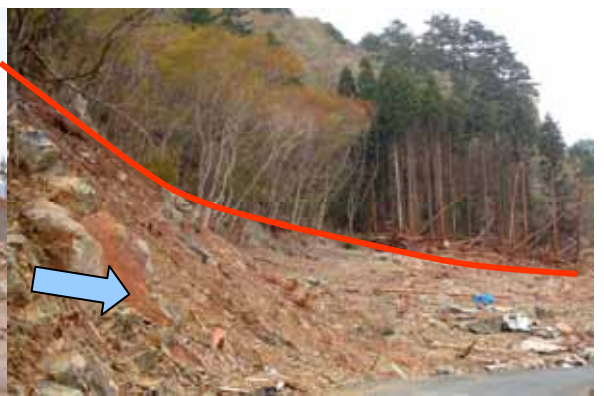
Fig. 41 防潮堤の側面を乗り越えた津波 （宮古市田老町摂待）
