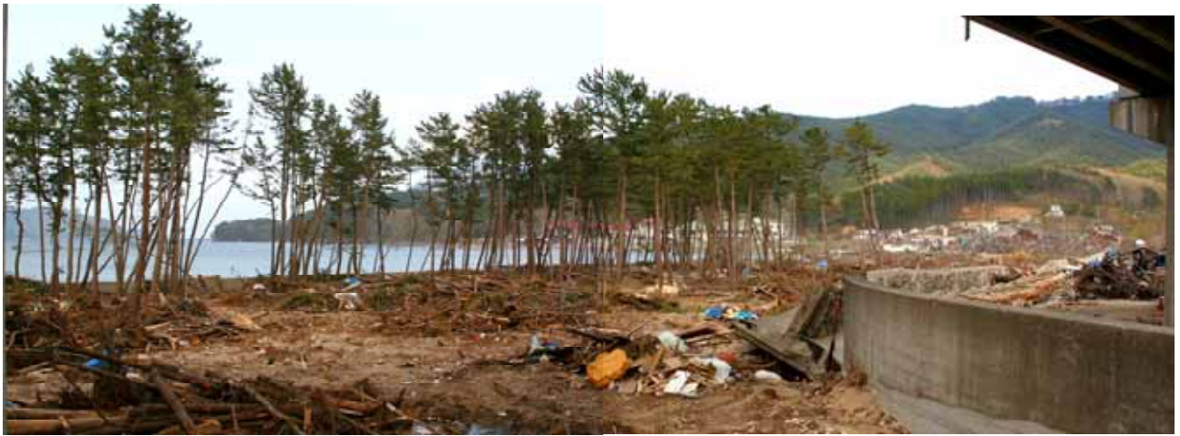
Fig. 9 津波が低い堤防を簡単に乗り越え、内側の海岸松林と集落を直撃、破壊（岩手県下閉伊郡山田町船越）
